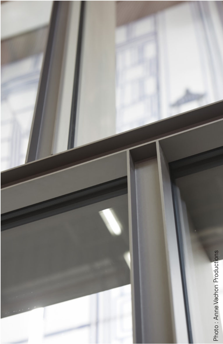
Tramage asymétrique et capot en U type industriel
